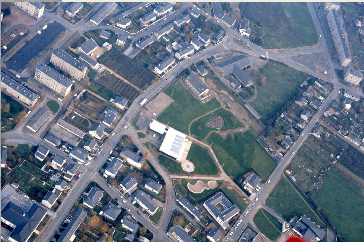
18. Photographie aérienne du quartier de Belle-Beille, Angers 1976, AMA, IGN 24 Fi_2001_05_b01_06_1976
