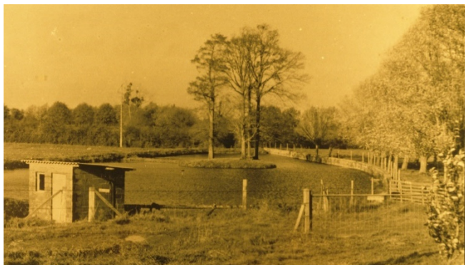
Septembre 1962 : Bois l'Abbé - première réserve d'eau creusée en décembre 1961 ; passerelle pour rejoindre l'île arborée
