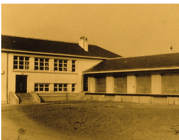
La station d'arboriculture fruitière, bâtiment de recherche et quai de déchargement des fruits- (1958)
