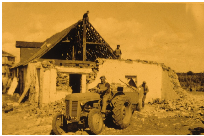
1956 : Bois L'Abbé Démolition Vieille Ferme – J.Mahé
